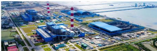
Nhà máy nhiệt điện duyên hải 2 Trà Vinh
